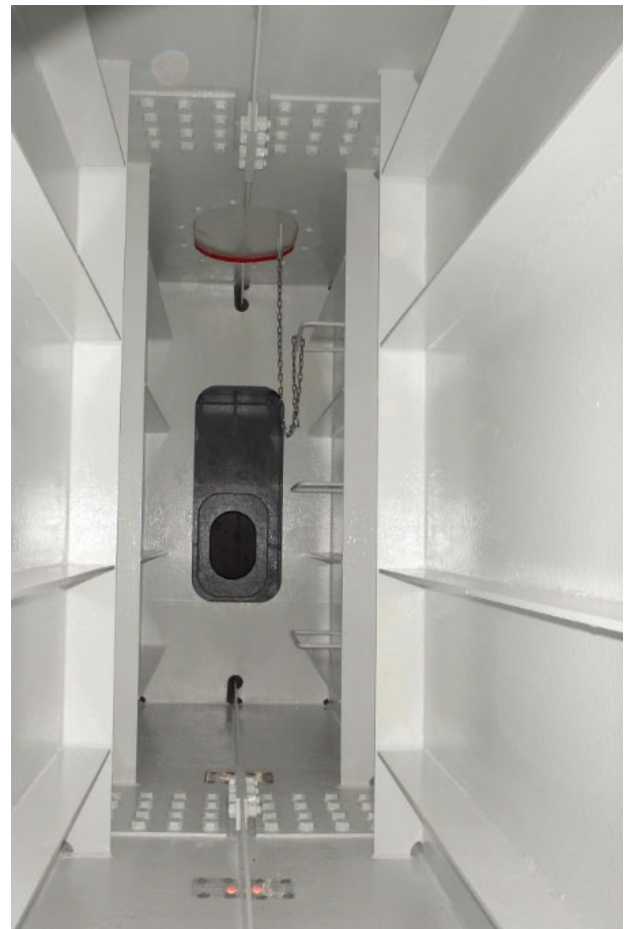
写真-13 主塔上部水平材内面補修状況
