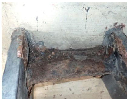
写真-16 タイプレート腐食状況
