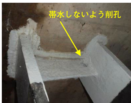
写真-19 削孔塗装状況
