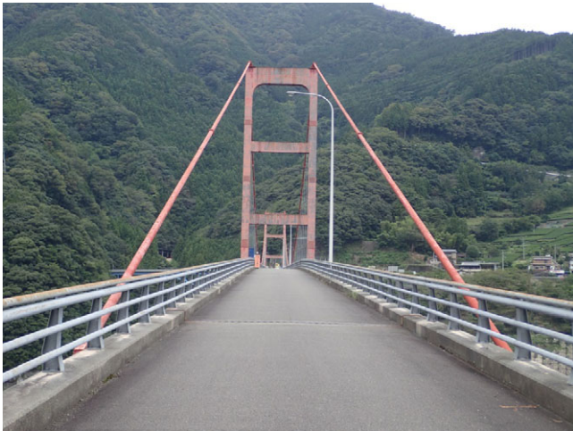
写真-10 主塔の劣化状況
