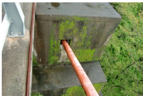
写真-15 スプレー室開口部状況
