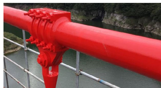
写真-4 メインケーブル等の補修状況
