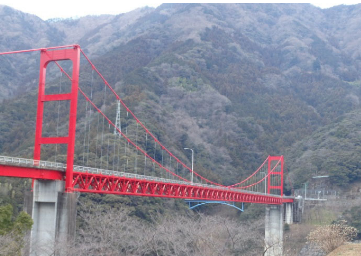
写真-14 主塔、補剛桁補修状況
