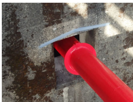
写真-18 水切り対策状況
