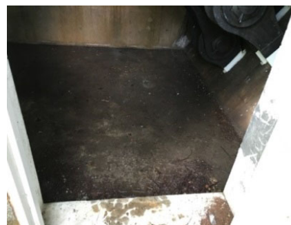
写真-17 スプレー室底板湿潤状況
