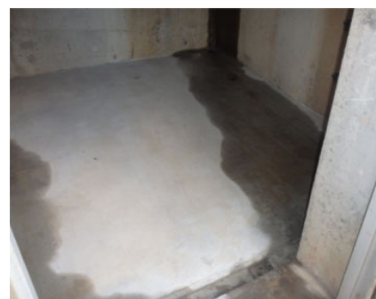
写真-20 排水勾配改善状況
