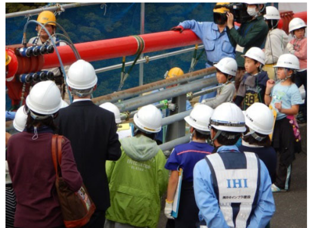
写真－ 24 ボルト交換見学状況
