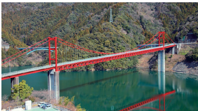
写真－1 大渡ダム大橋全景（補修後）
