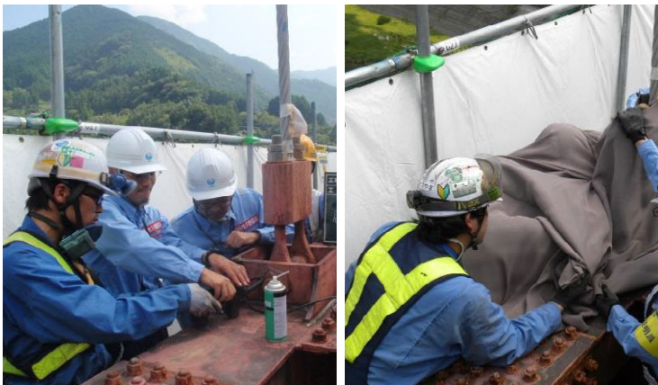
写真-12 亀裂調査状況
