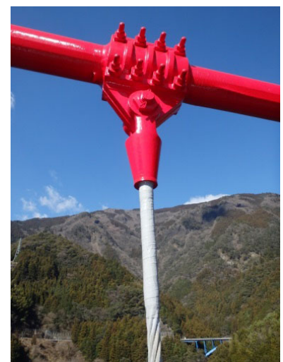
写真-9 ハンガーロープの補修状況
