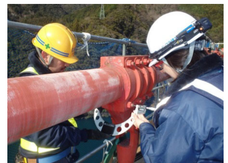
写真-5 ケーブルバンドボルト軸力調査
