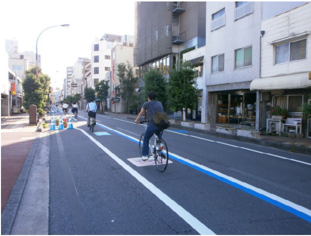
図-4 自転車走行レーン設置状況
