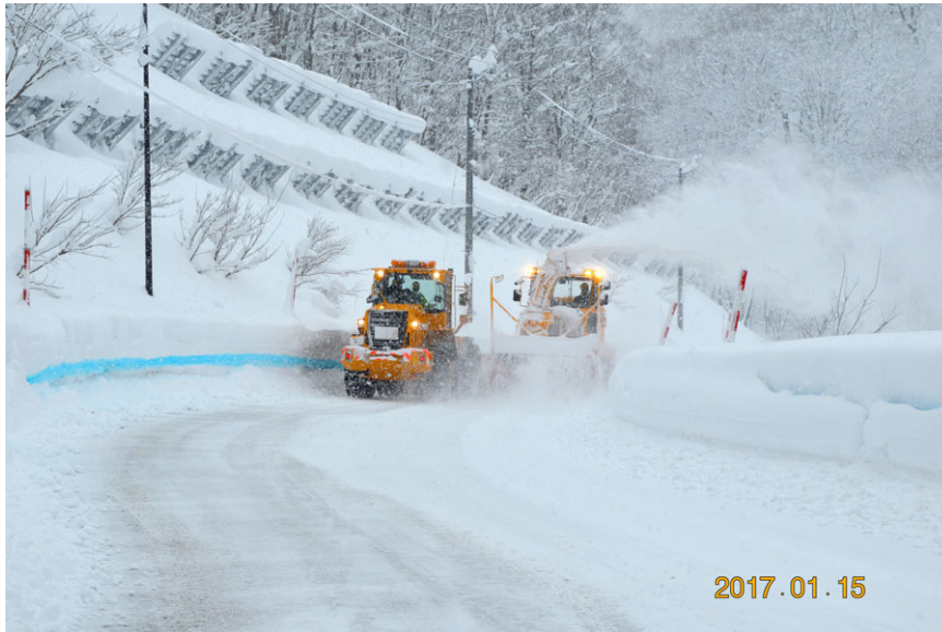
写真-5 除雪状況とブルーライン
