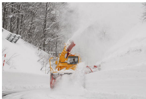
写真 1-2 試験除雪状況
