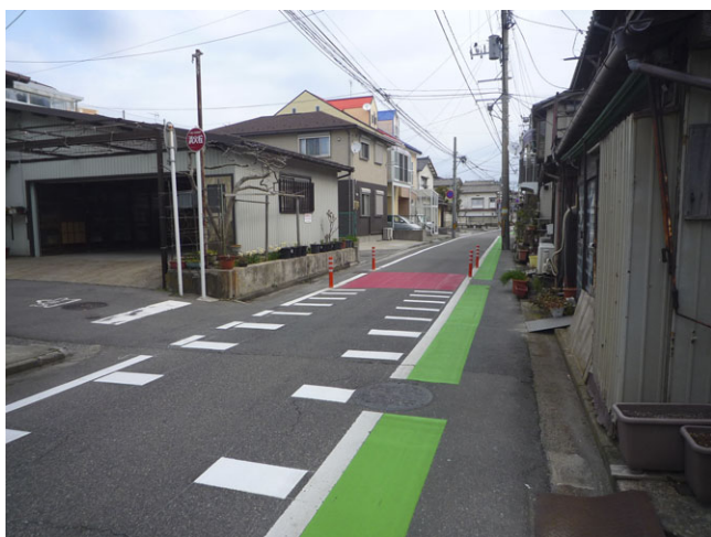
狭さくの設置状況（平成 29 年 4 月）
