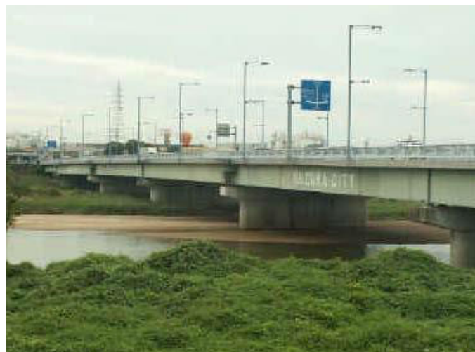
緊急輸送道路上の橋
