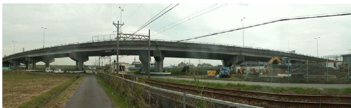
矢橋肥田高架橋
