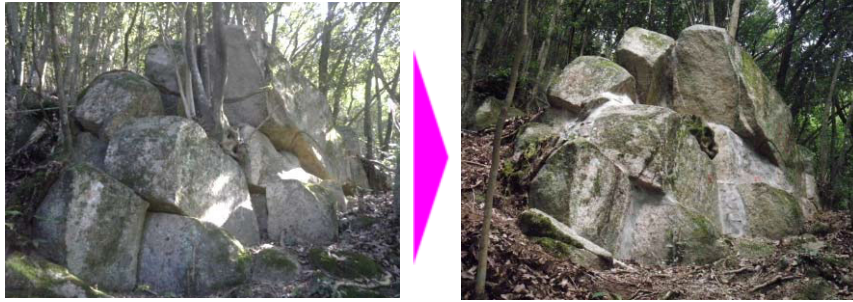
■実施例（岩接着、伐採工）
