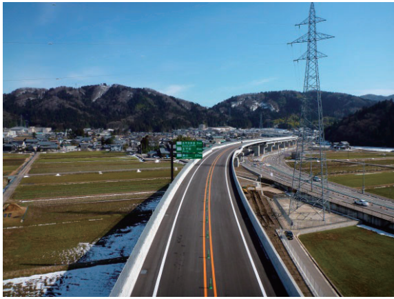
写真-3 松岡高架橋
