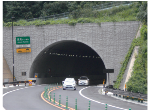
写真-4 浅見トンネル
