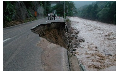
写真-5 福井豪雨時 (H16) の被災状況
