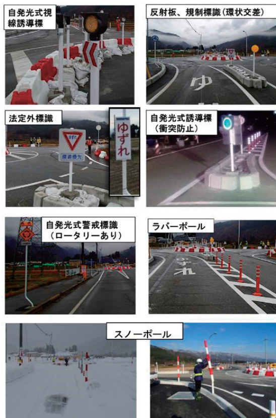
図-4 仮設安全施設
