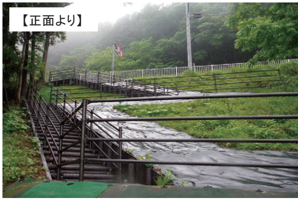
写真1 完成した津波避難階段
