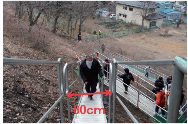
写真5 仮設階段による避難訓練
