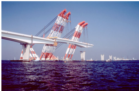
沖合部の橋桁架設（大型重機船による）
