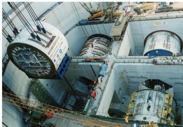
シールドマシンの人工島への吊り下ろし
