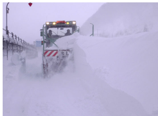
図 3 道道の除雪作業の状況
