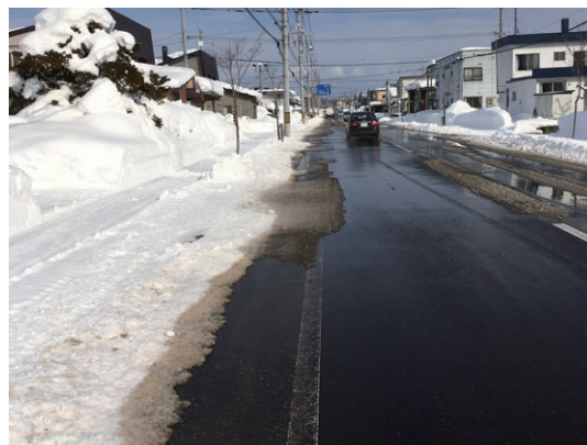
図 12 排雪後の道路状況「2月3日市道7条線」
