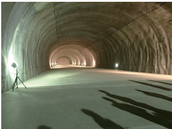
写真3 分岐トンネル
