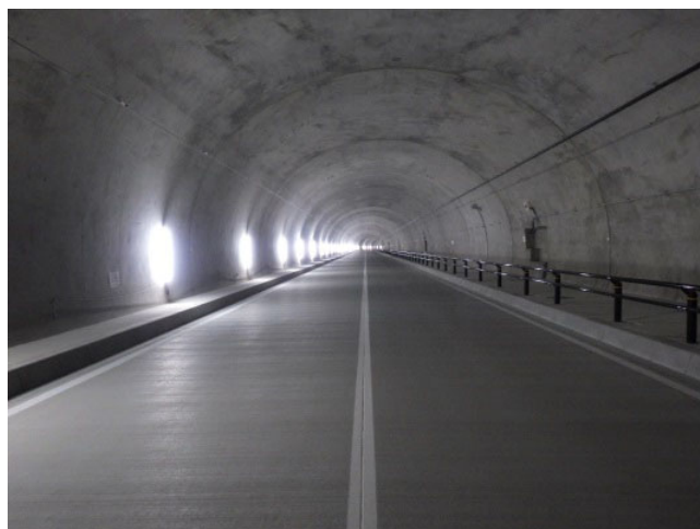
写真2 トンネル内（舗装完成状況）
