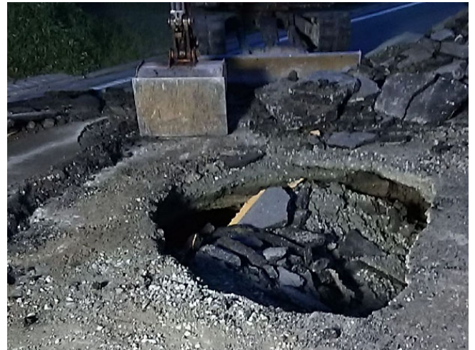
写真-1 道路巡視により発見した空洞事例
