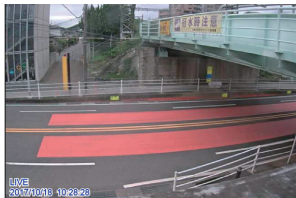
写真-3 遠隔監視状況（戸畑区 一枝アンダーパス）
