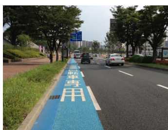
全面（1.5m）カラー舗装
