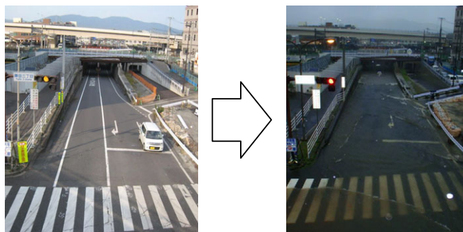
写真-1 アンダーパス（八幡西区）の冠水状況（右が冠水時）
