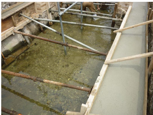
【沓座コンクリート打設状況】
