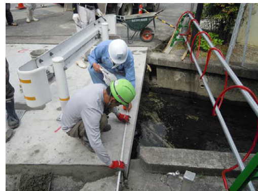
【防護柵アンカー削孔】
