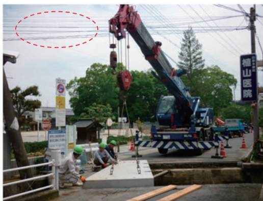
【床版取り替え状況①】
