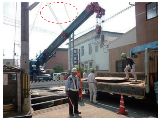
【床版取り替え状況②】
