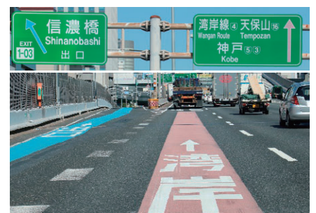
色彩を用いた案内による安全対策
