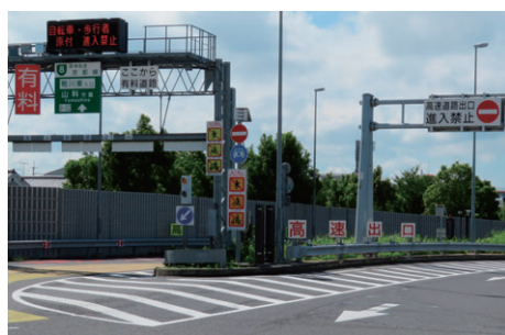
逆走・誤進入対策例
