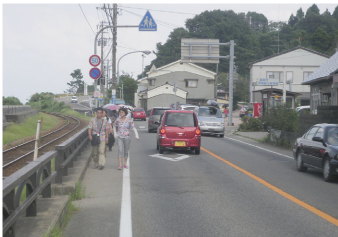
一般国道415号の現状
