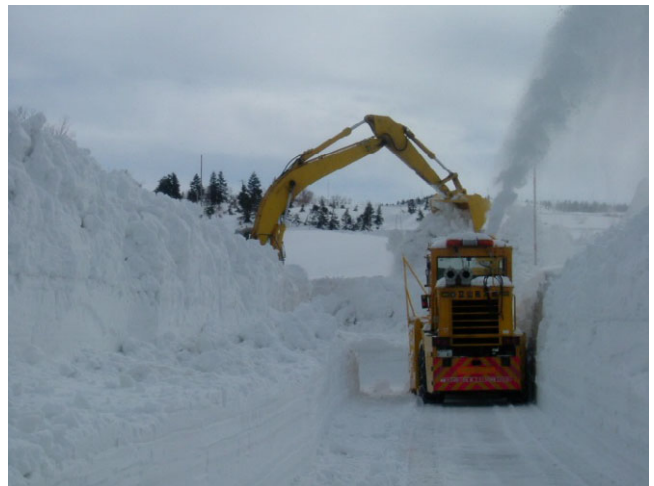
写真-10 ③ 拡幅除雪(バックホウ+ロータリ車)
