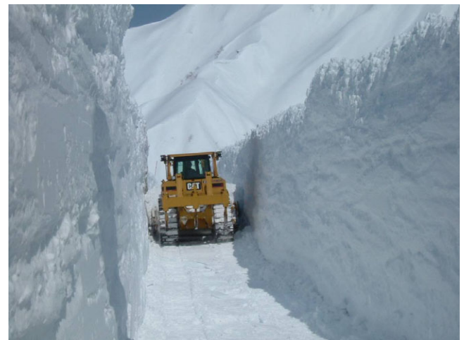
写真-8 ②1車線除雪：ブルドーザ
