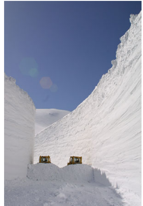
写真-12 ブルドーザ2台による雪壁の切下げ
