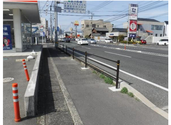
写真4 横断防止柵の設置事例
