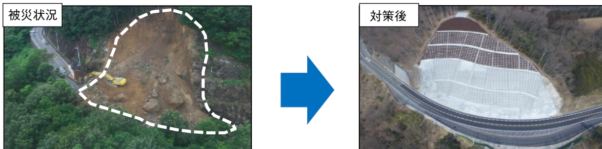
一般国道182号の再度災害防止対策（広島県福山市）
