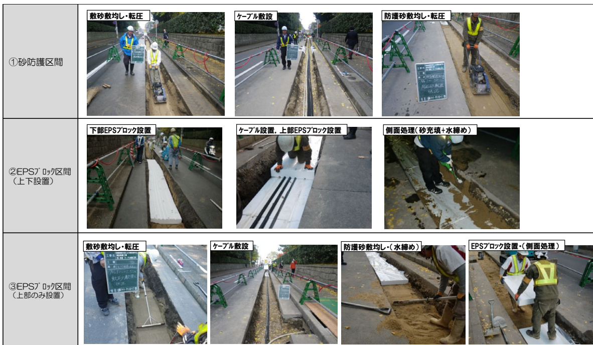
ケーブル敷設状況写真
