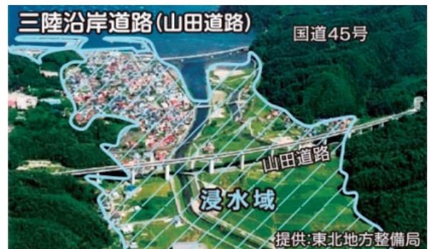
図3 高架橋により津波浸水域を通過
