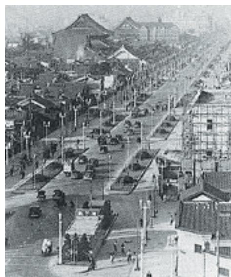
写真-1 拡幅当時の御堂筋 （出典：大阪歴史博物館）
