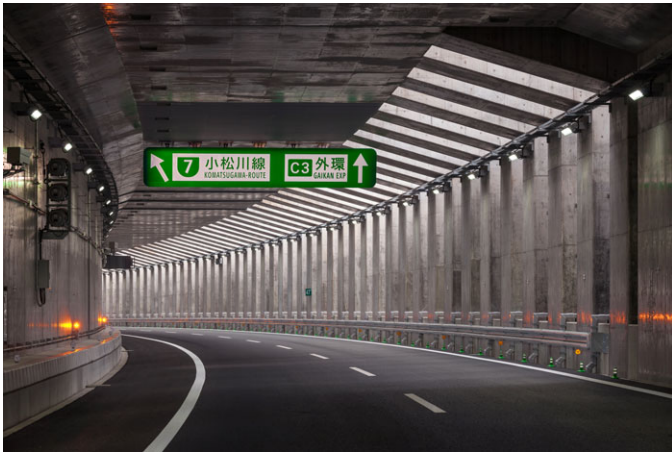
写真－1 掘割半地下区間
