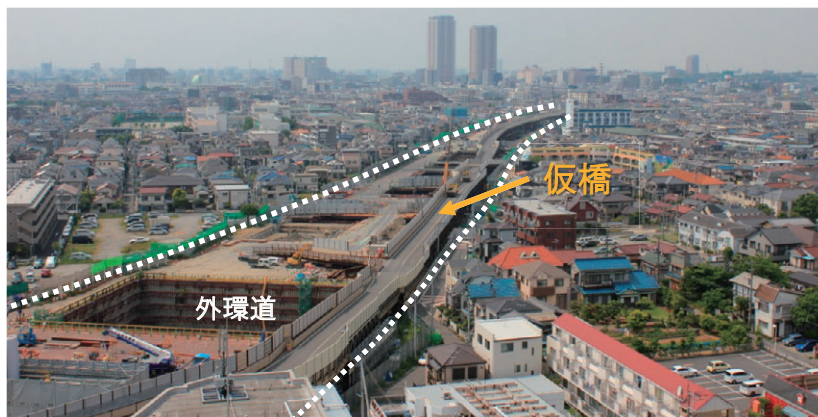
図-10 工事用仮橋の設置状況
