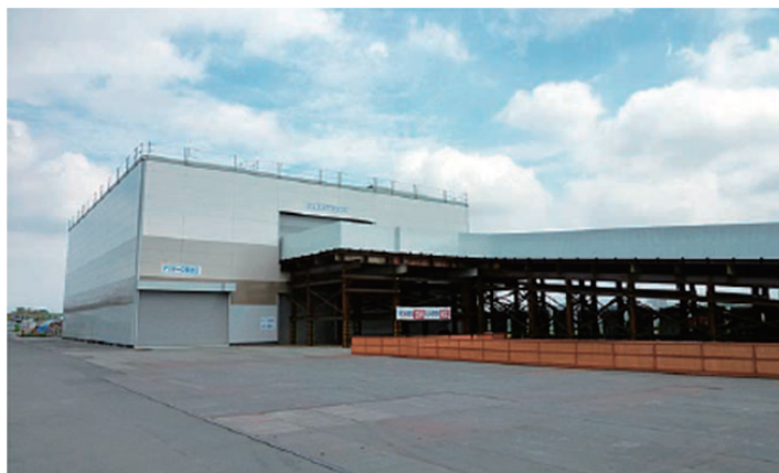
図－11 仮設コンクリートプラントの設置状況
