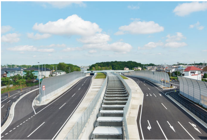
写真－3 国道 298 号と掘割スリット上部
