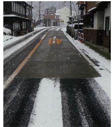
写真3 無散水融雪装置（融雪状況）
