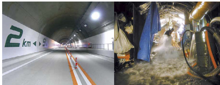
図-4 開通後の状況（左）および湧水の発生状況（右）
