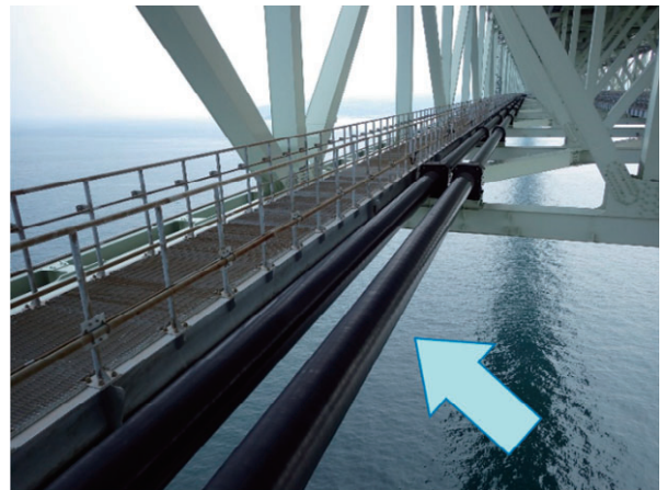
【写真-1】 明石海峡大橋に設置されている送水管
