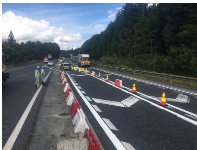
写真－2 中国道 北房～新見間（中央分離帯開口部状況）
