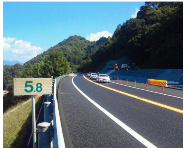
写真-8 広島呉道路 坂南～天応西間
