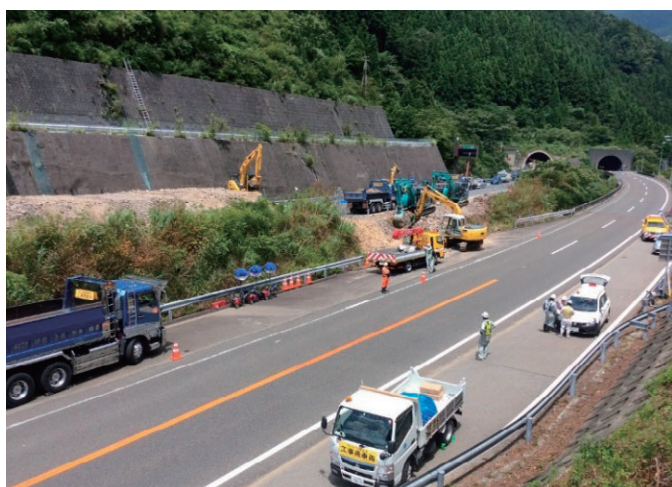
写真-6 高知県 新宮～大豊間（中央分離帯開口部施工状況）
