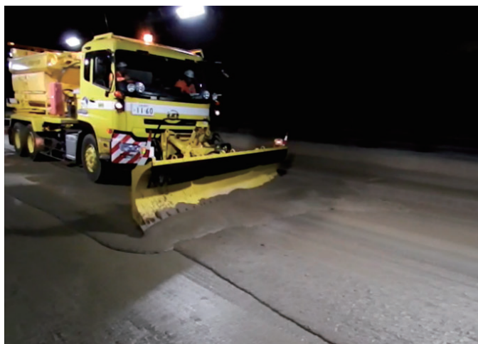
写真-4 山陽道 志和 TN 内土砂撤去（除雪車）
