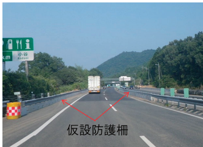
写真-5 山陽道 仮設防護柵による復旧状況
