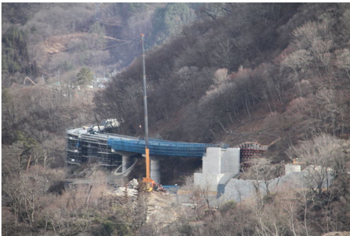
付け替え町道（川原湯地区：整備中）
