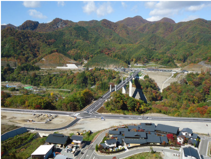
ハッ場大橋と両岸の代替地
