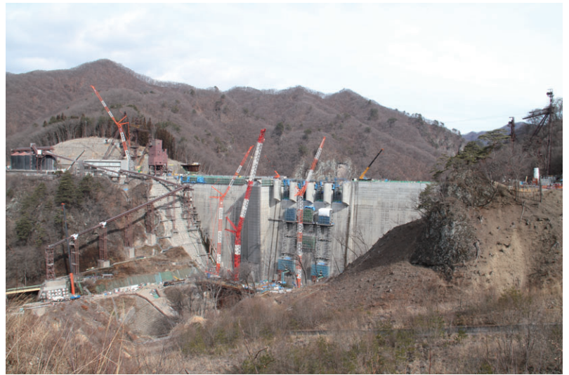
ハッ場ダム堤体（吾妻川上流側より）平成31年2月
