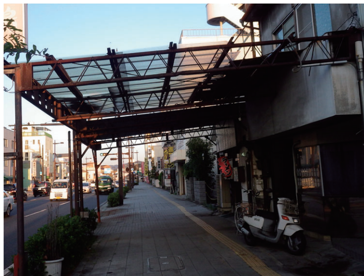
不法占用されている支柱付きアーケード
