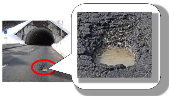
図－1 ひび割れ及び路面の剥離による「穴ぼこ」
