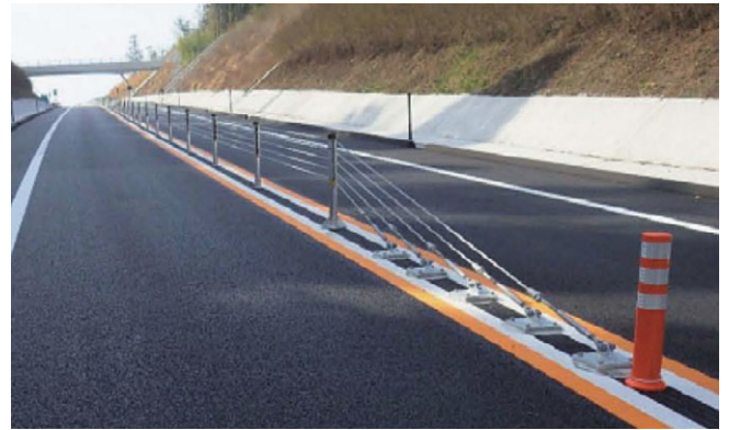
写真-3 ワイヤロープの設置
