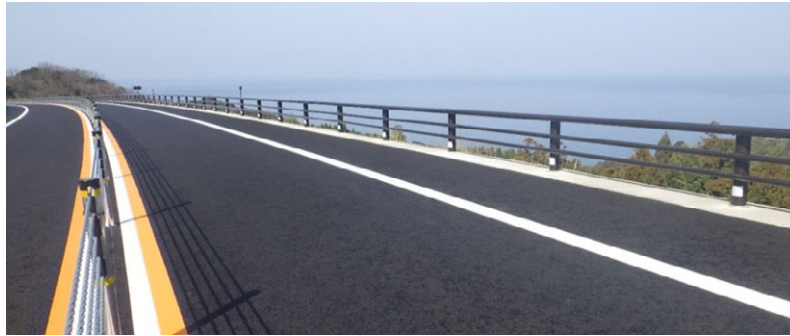
写真－４ 眺望が開けた区間の防護柵
