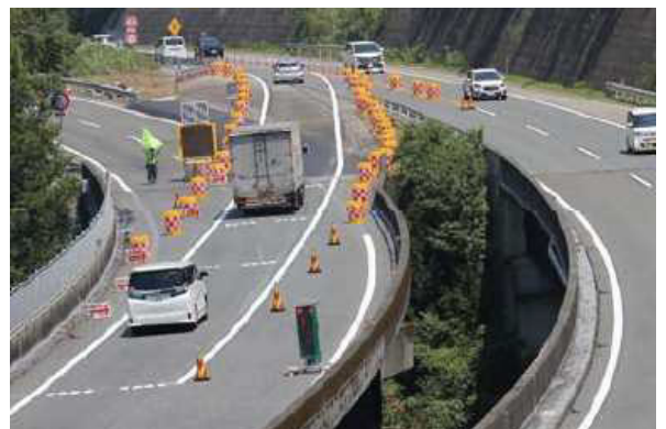
図－4 対面通行による通行再開
