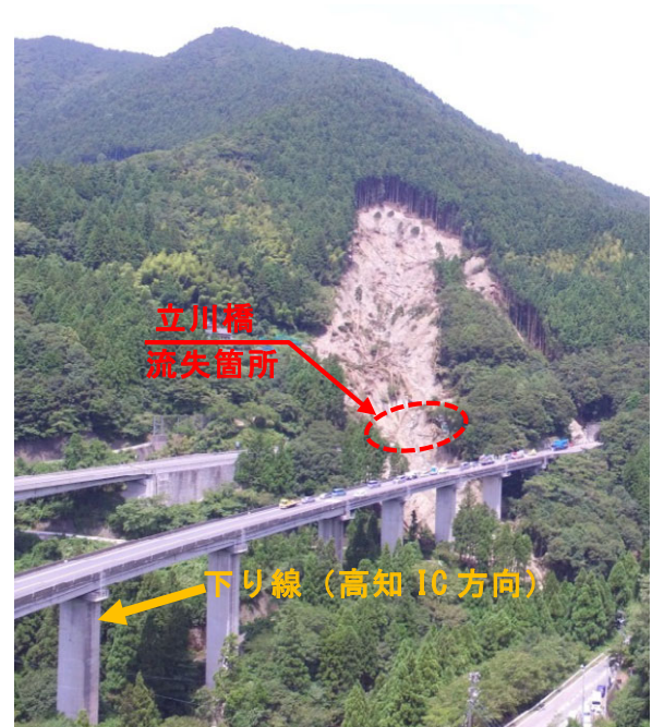
図－3 高知自動車道立川橋被災状況
