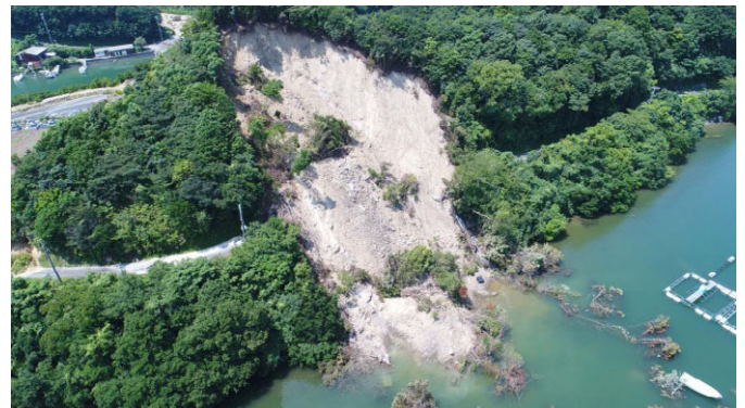
写真－3 土砂崩れ状況
