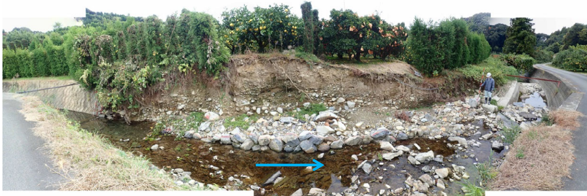
写真-10 宇須々木川被災状況
