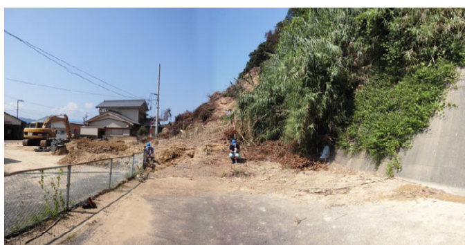
写真－6 市道大島南線法面崩落（被災直後）
