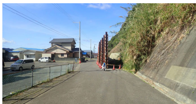
写真－7 市道大島南線法面崩落（崩土撤去後）
