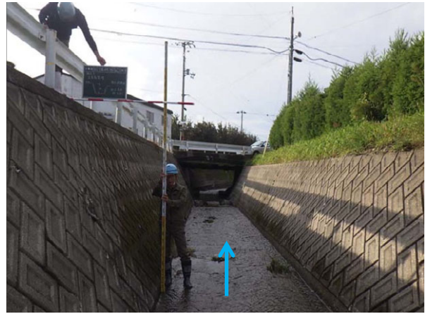
写真-13 宇須々木川河川埋塞土砂撤去後
