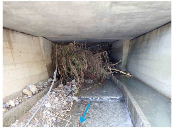
写真-9 河道閉塞状況
