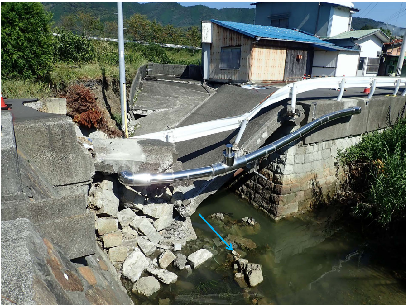
写真-14 脇の川橋被災状況
