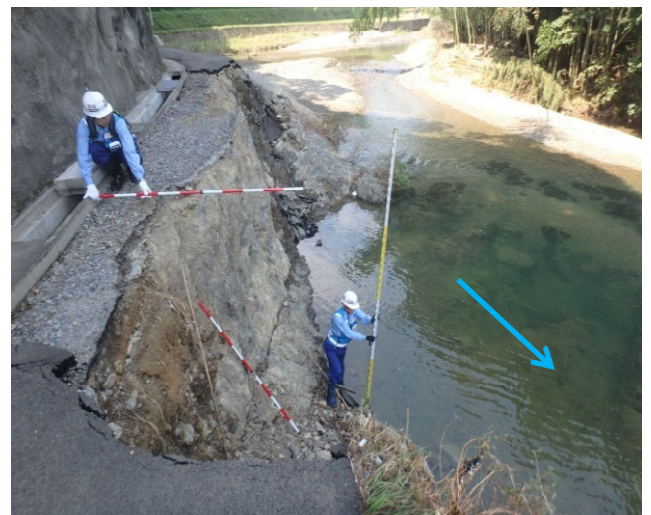
写真-11 TEC-FORCE 現地調査状況
