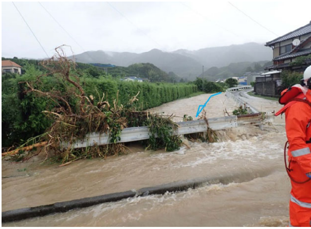
写真-8 宇須々木川氾濫状況
