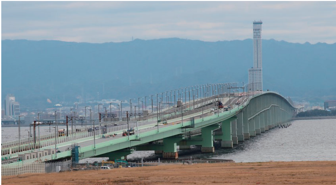
写真－10 架設完了状況
