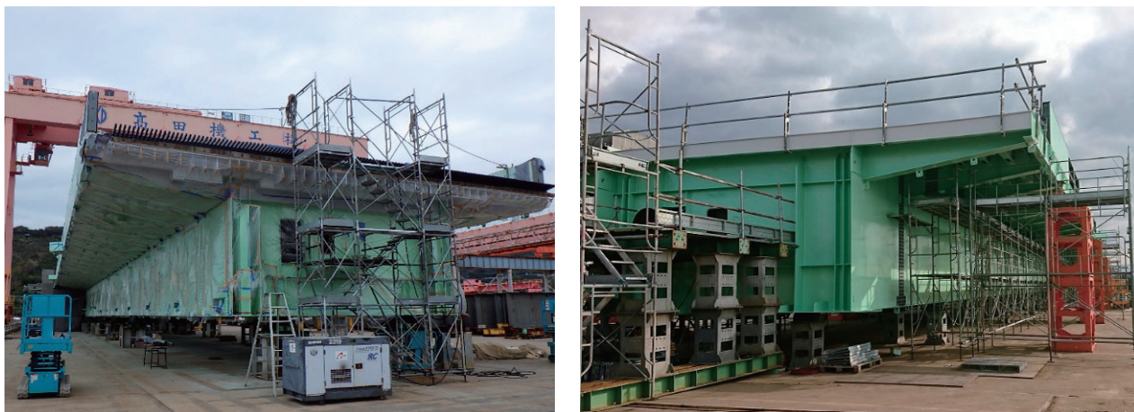
写真－8 橋桁組立状況 (左：A1～P1、右：P1～P2)
