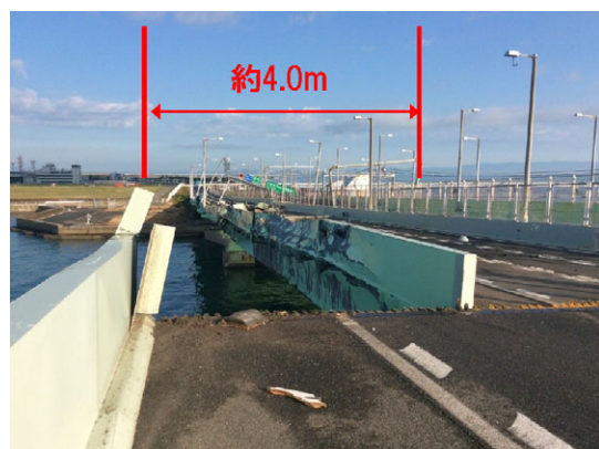
写真-1 被災状況①
