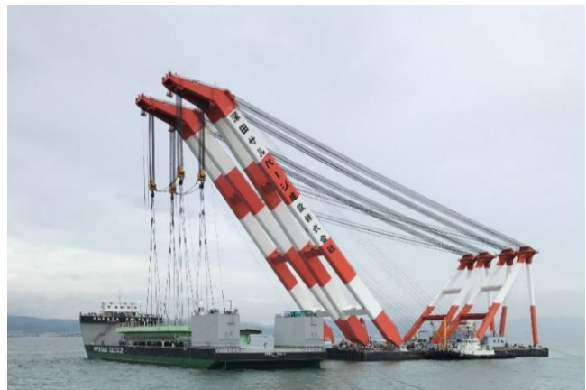
写真-7 台船への積込状況
