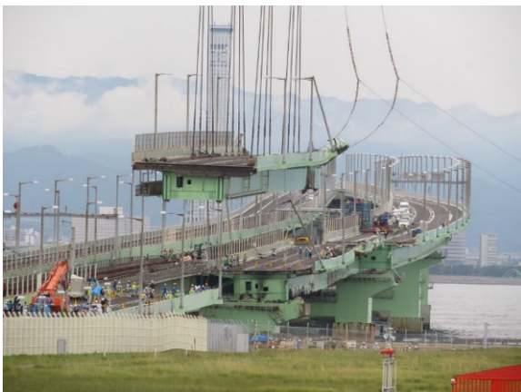
写真-6 橋桁の撤去状況
