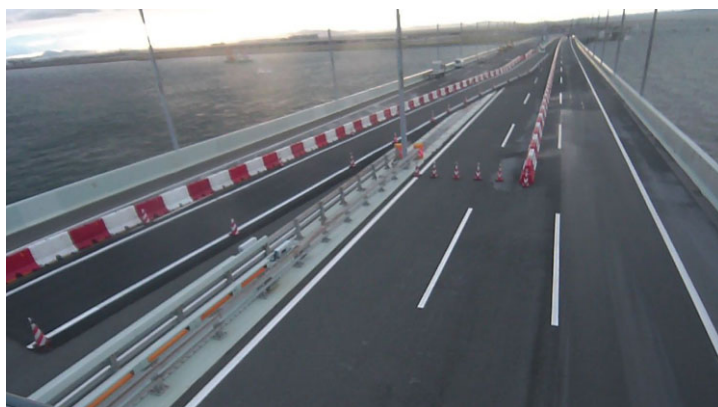
写真－5 渡り線部
