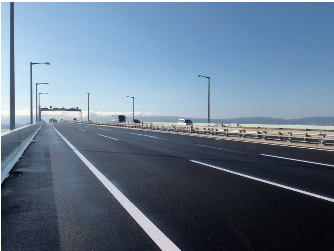
写真－11 完全復旧完了状況
