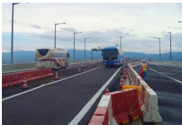
写真－4 対面通行状況
