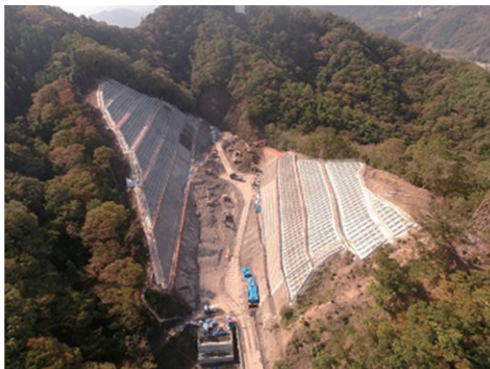
写真3 切土の現地状況
