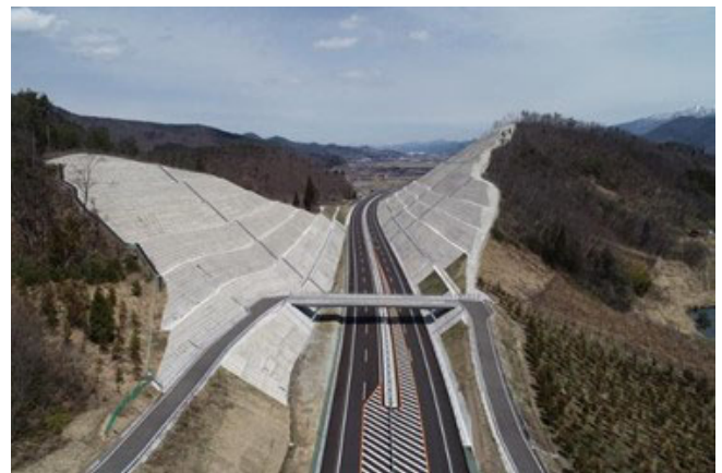
写真－2 堂満山長大切土のり面
