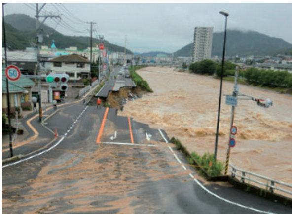
写真-1 国道2号被災状況 (H30.7.7)
