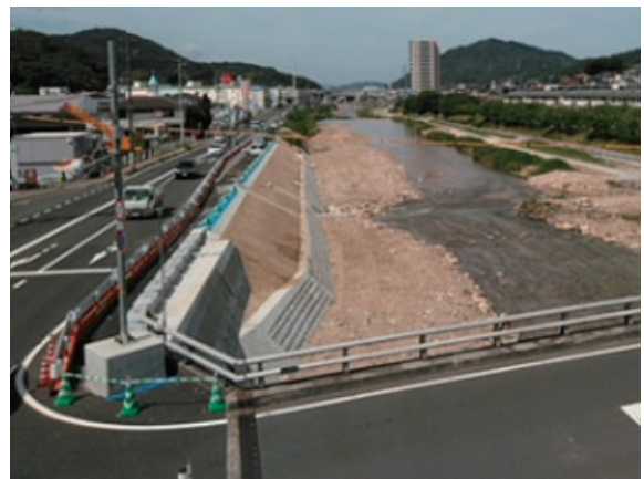
写真-2 国道2号復旧状況 (R1.6.17)
