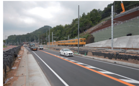
写真-5 復旧完了
