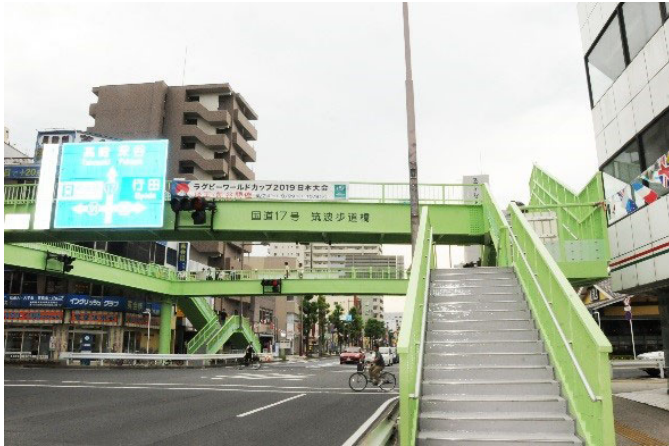
筑波歩道橋の補修・塗装工事完成状況
