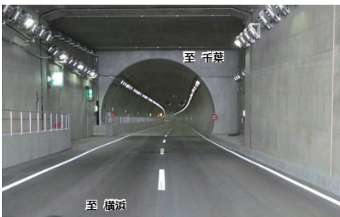
写真-2 トンネル坑内(開通前)
