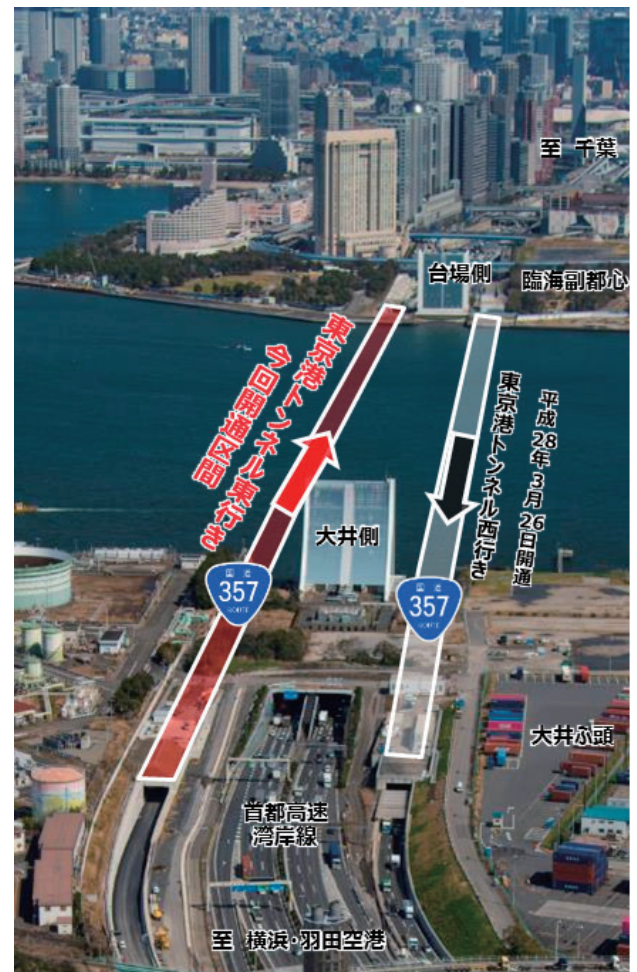
写真-1 国道 357 号 東京港トンネル付近
