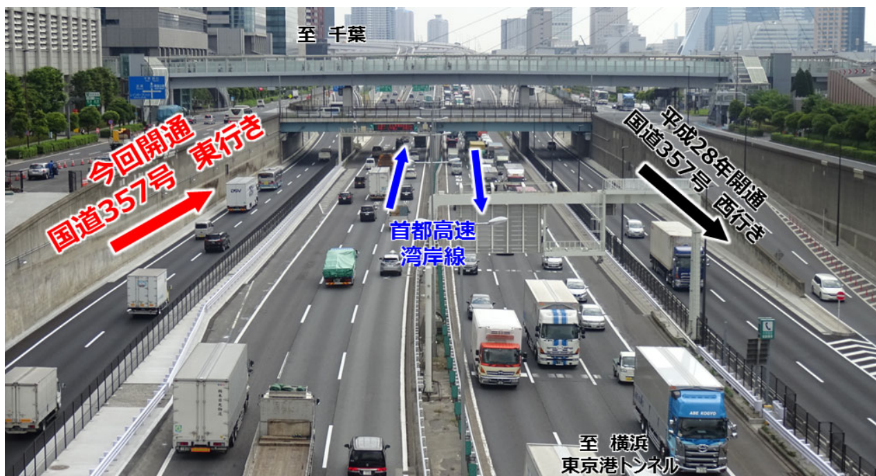
写真-7 国道357号 東京港トンネル（台場側）から千葉方面
