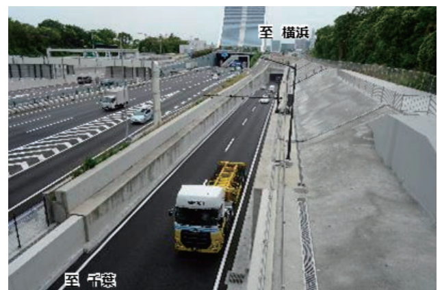
写真-3 トンネル坑口(台場側)
