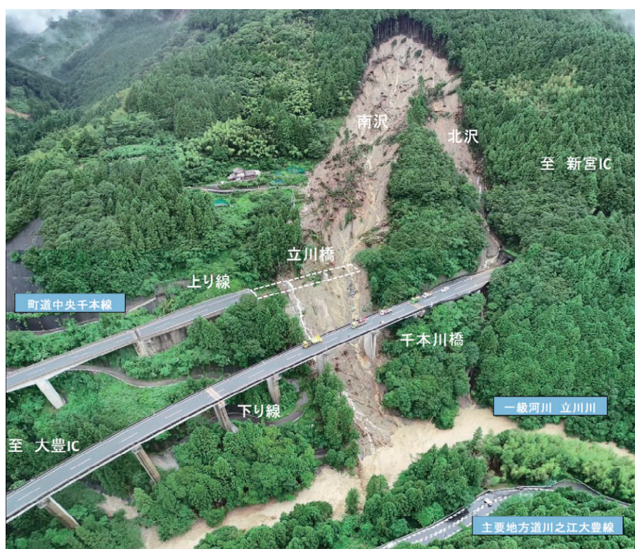
写真1 被災状況(平成30年7月7日撮影)
