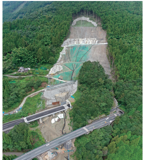
写真11 崩落斜面对策状況（令和元年9月13日撮影）
