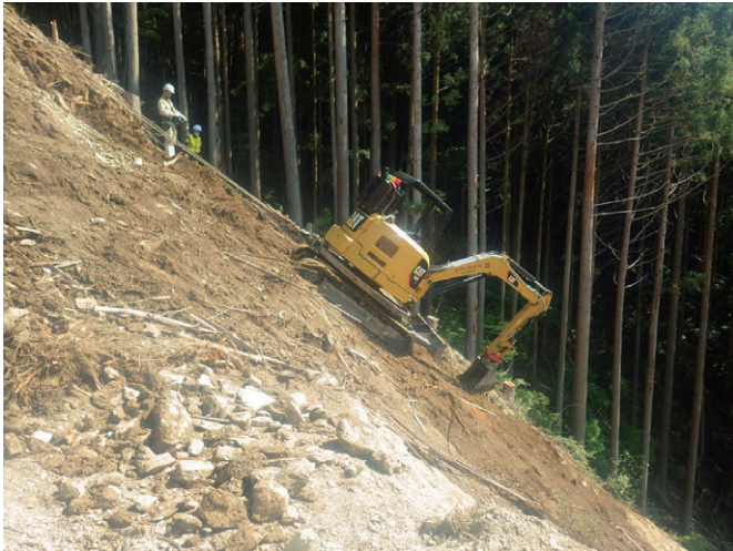
写真10 無人バックホウ施工状況
