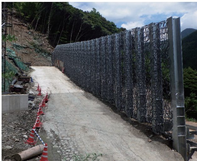
写真13 流向制御工設置状況
