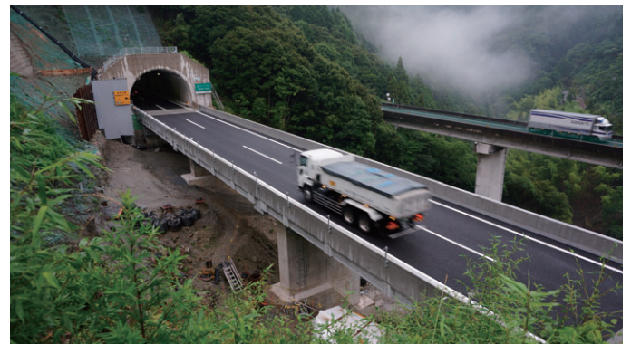
写真14 復旧後の立川橋
