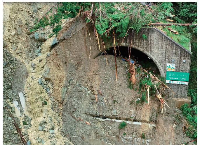
写真 7 トンネル坑口部土砂堆積状況
