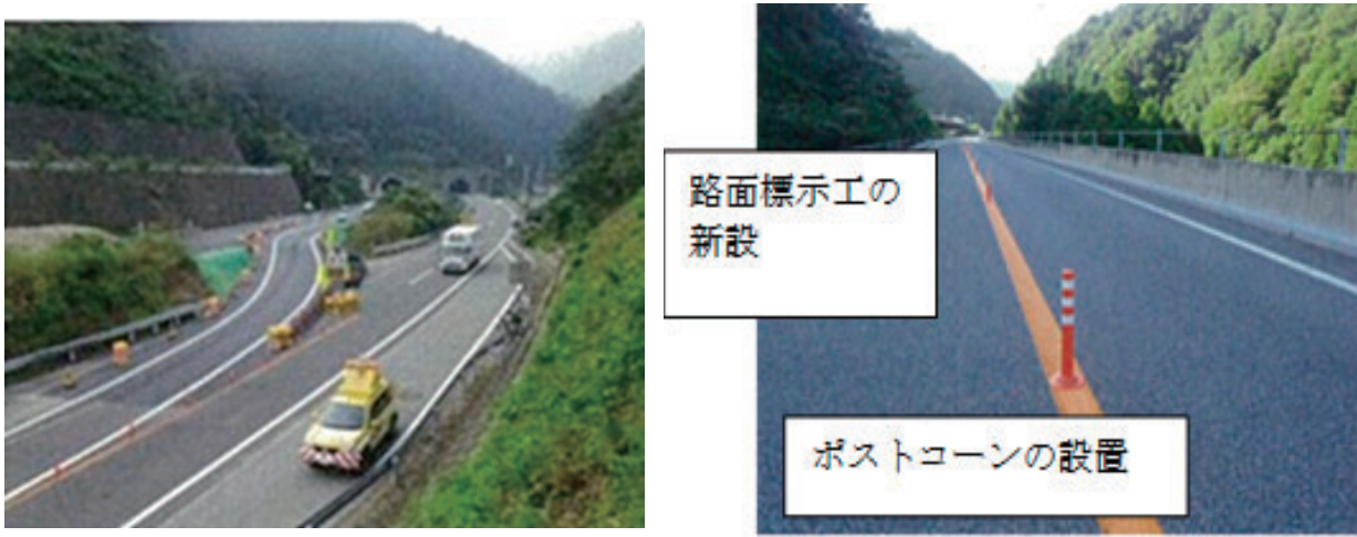
写真4 擦り付け箇所、ポストコーン等設置状況
