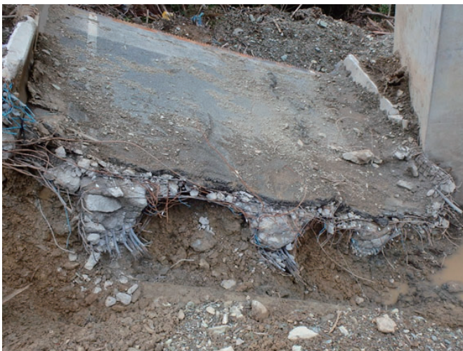
写真 6 千本川 P4 橋脚付近で発見された立川橋の一部
