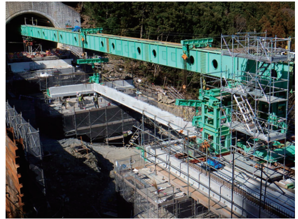
写真12 架設桁による上部工架設状況
