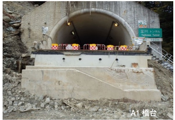
写真8 残存下部工状況
