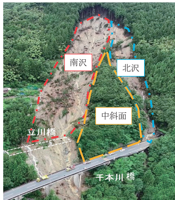
写真5 山腹斜面状況
