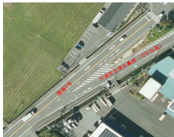
図4 国道8号と市道Y字交差点の航空写真
