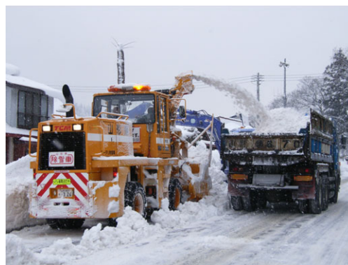
運搬排雪作業状況
