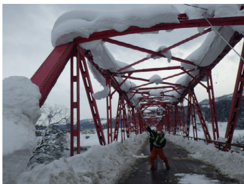
トラス橋の雪庇撤去作業状況
