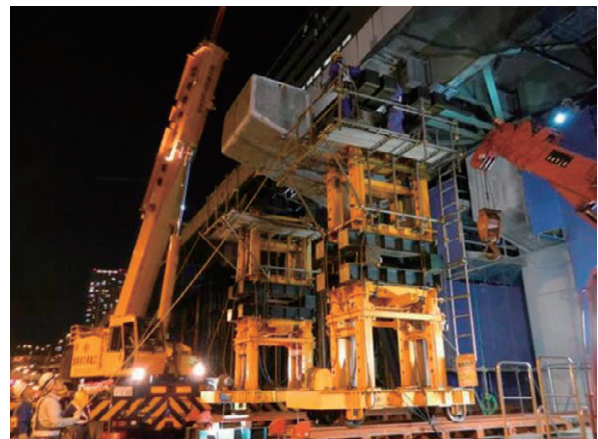
橋梁を仮受けしての既存橋脚梁撤去
