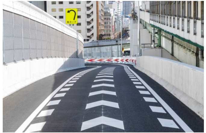
西船場 JCT 信濃橋渡り線部
