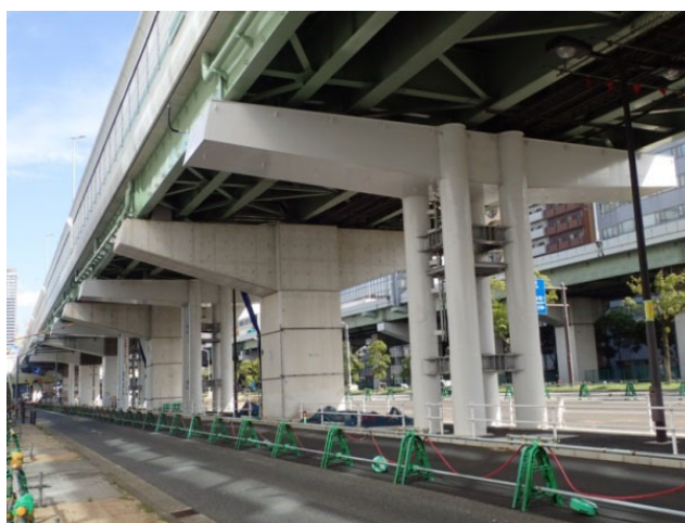
鋼管集成橋脚
