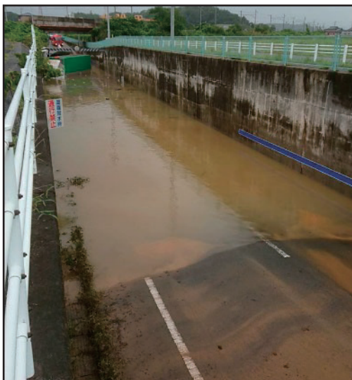
写真(事故状況)
