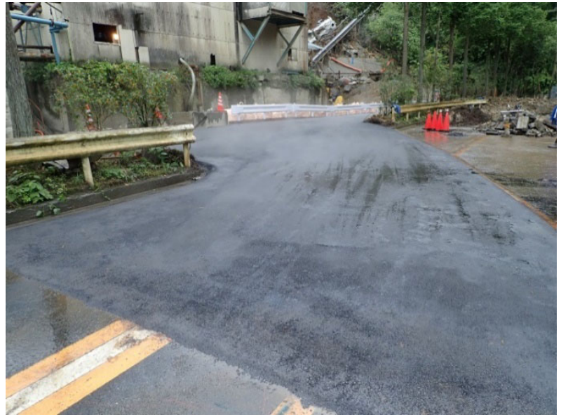
仮設道路設置
