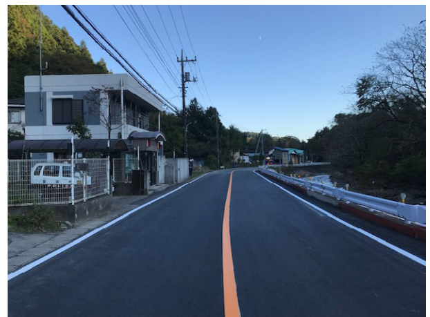
仮設道路設置
