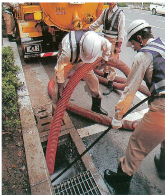
道路側溝・樹の浚渫作業
