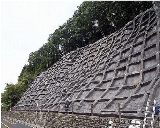
斜面の安全対策
