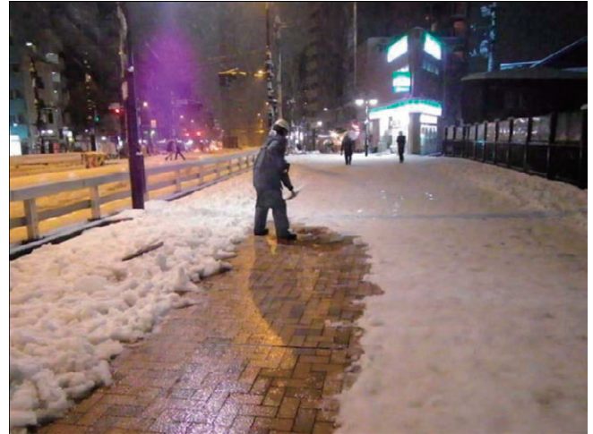
除雪作業の様子（区部：歩道）
