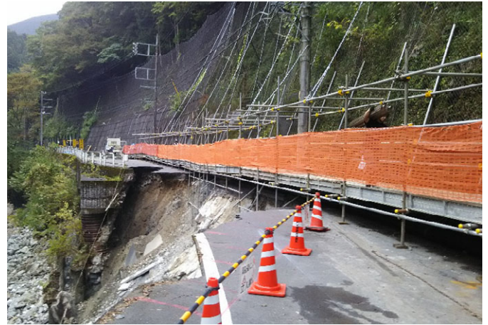
仮設歩行者通路設置
