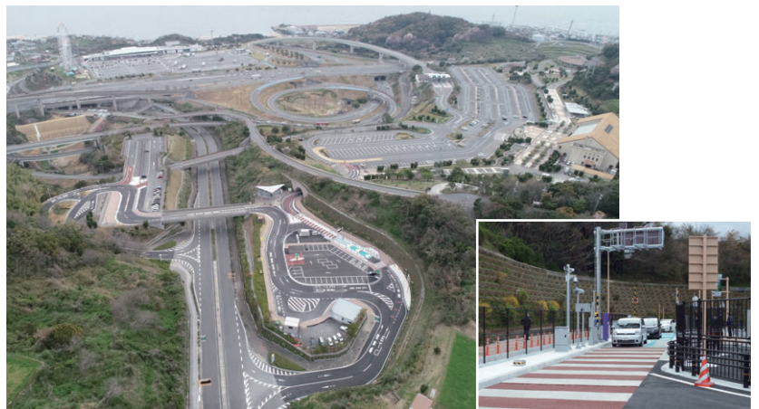
写真 開通後の様子
