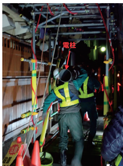
写真-7 小型ボックスの施工状況（電力）
