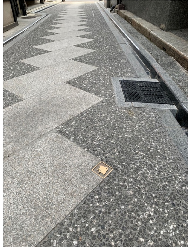
写真-11 抜柱を終えた工区の舗装復旧
