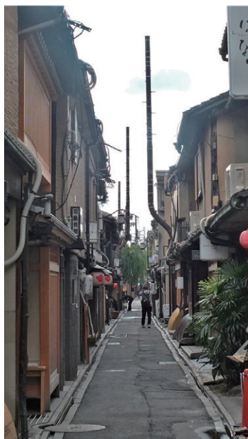
<ケーブル撤去後>
