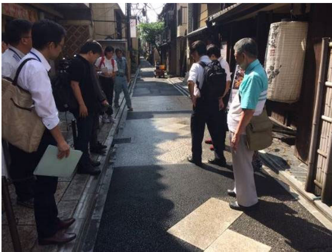
写真-10 試験施工を確認している様子
