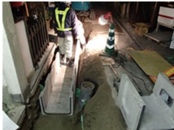
写真-7 小型ボックスの施工状況（電力）
