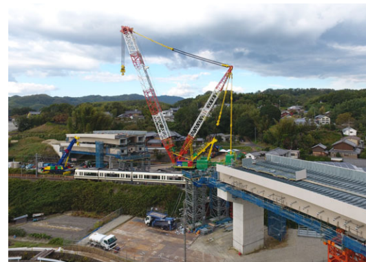
J R 高架部 鋼桁一体架設に向けて (1250t 吊クレーン)
