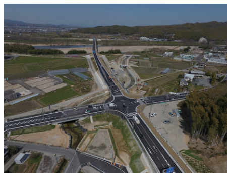
写真② (主) 天理加茂木津線交差点周辺
