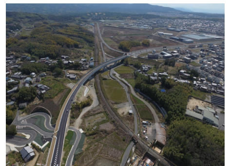
写真③ (主) 天理加茂木津線から 木津中央地区を望む
