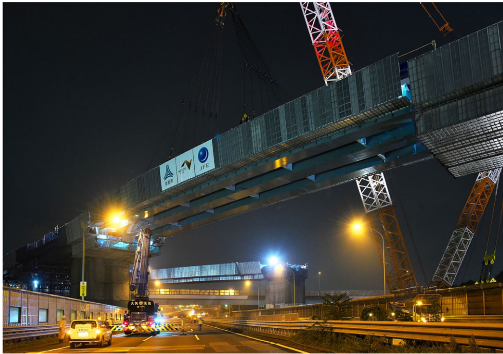
参考 クローラクレーン一括架設状況
